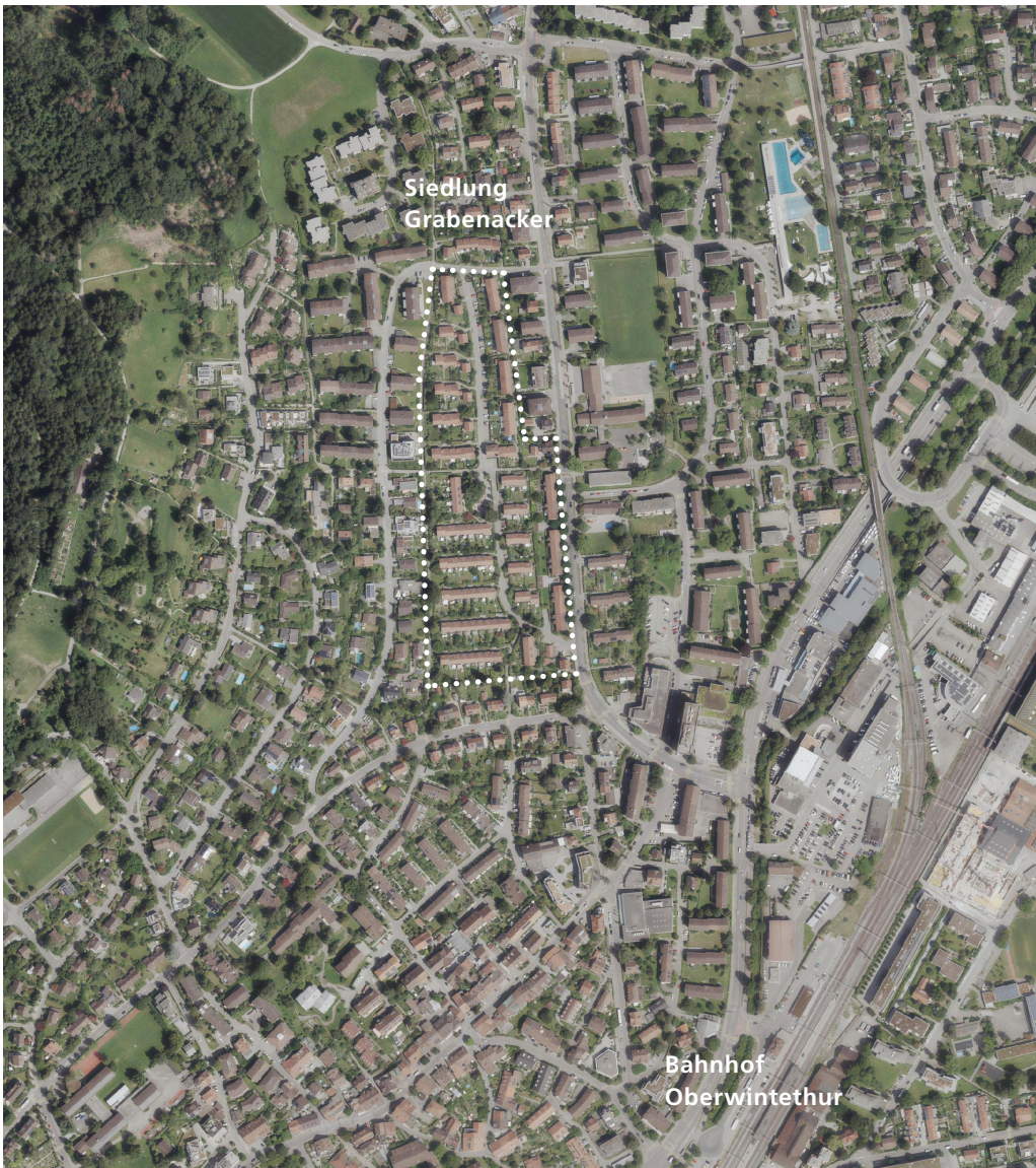
Siedlung Grabenacker, Oberwinterthur (Luftbild Bestand 2021)
